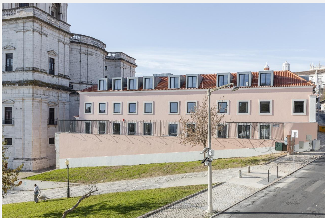
CRECHE DO CONVENTO DO DESAGRAVO
